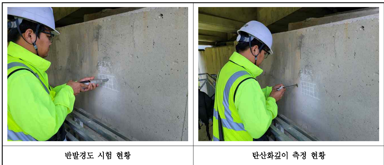
【사진 13.4.1】 콘크리트 내구성조사 현황
