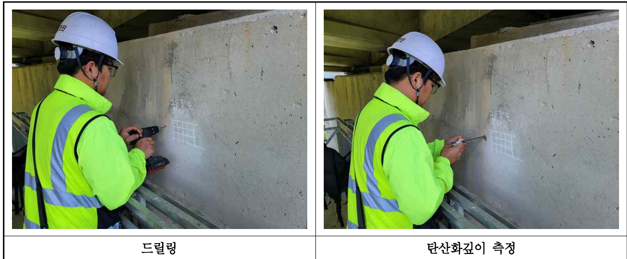
【사진 13.4.3】 탄산화 깊이 측정 현장사진
