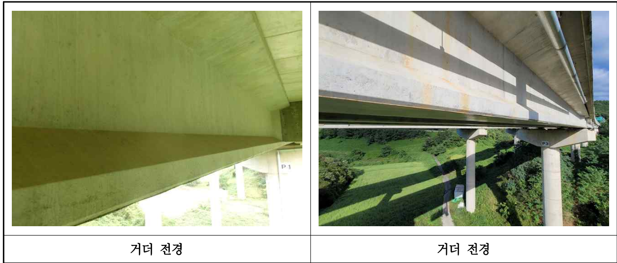
【사진 13.3.29】 거더 전경
