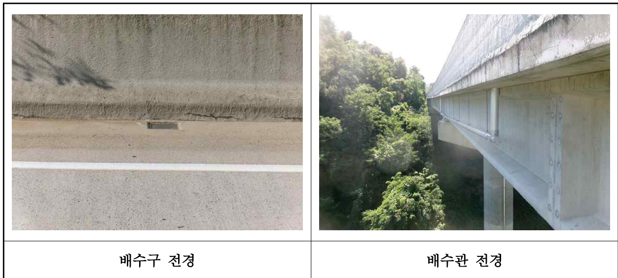
【사진 13.3.22】 배수시설 전경
