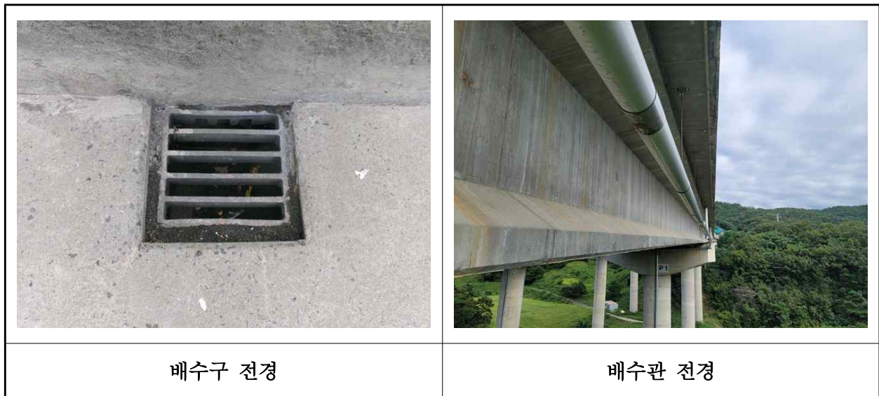
【사진 13.3.47】 배수시설 전경
