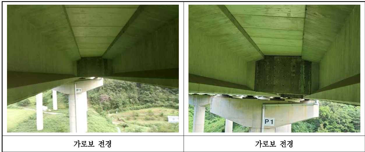
【사진 13.3.31】 가로보 전경
