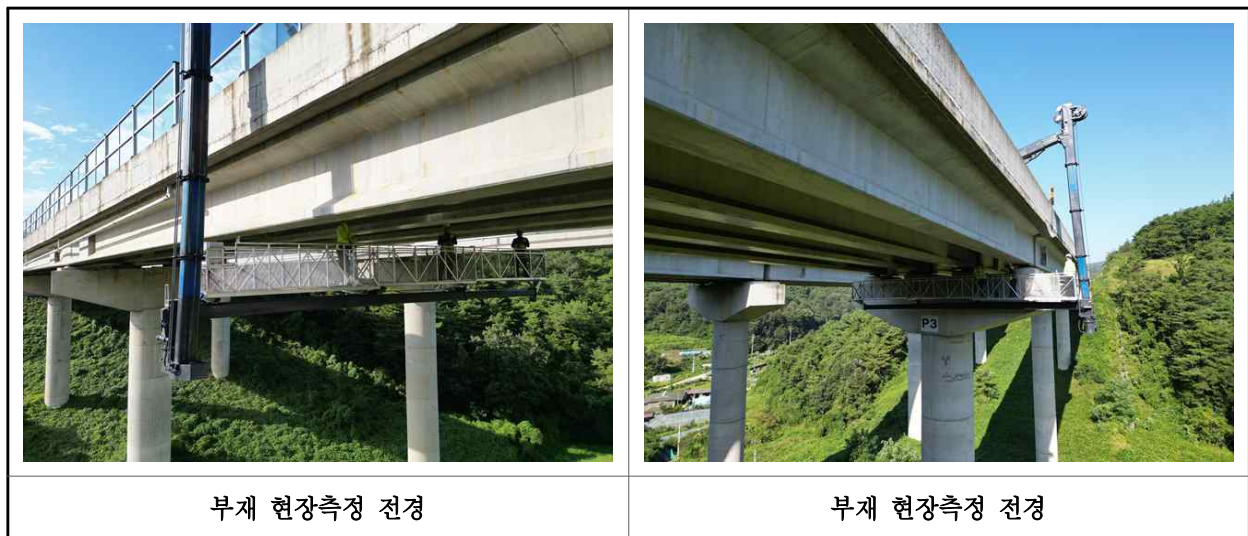
【사진 13.2.1】 부재 현장측정 전경
