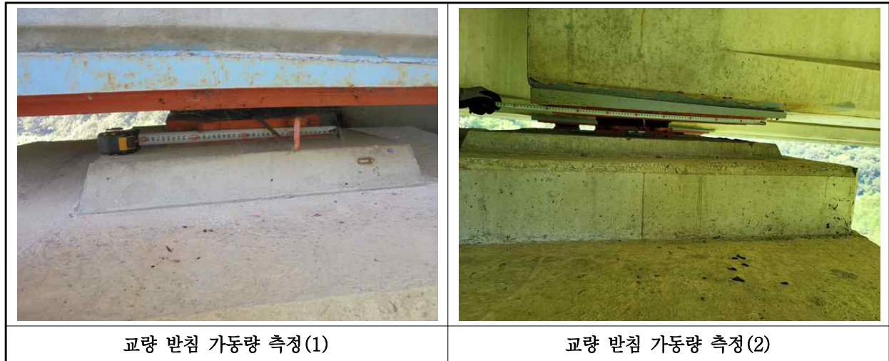
【사진 13.3.16】 교량받침 이동량 측정
