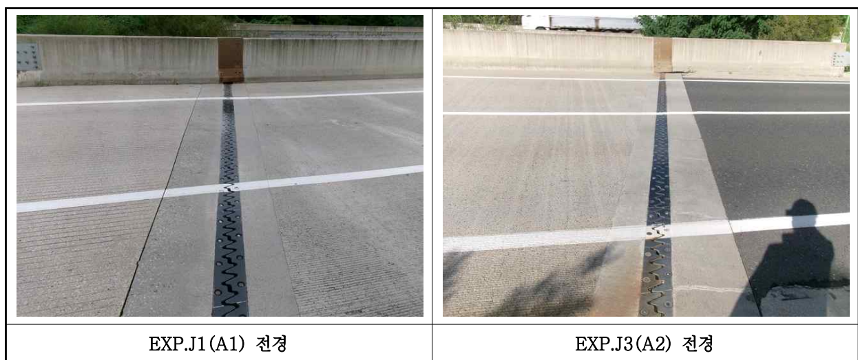
【사진 13.3.42】 신축이음장치 전경
