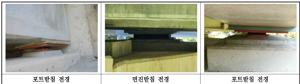
【사진 13.3.13】 교량받침 전경
