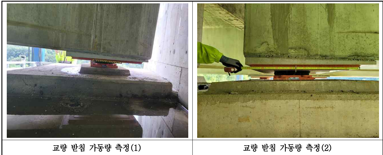
【사진 13.3.41】 교량받침 이동량 측정
