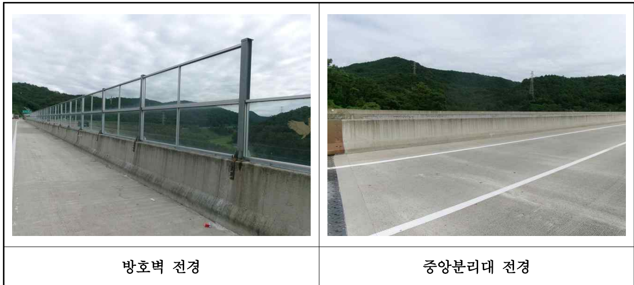
【사진 13.3.49】 방호벽 및 중앙분리대 전경
