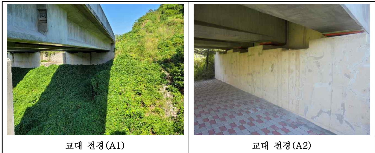
【사진 13.3.8】 교대 전경
