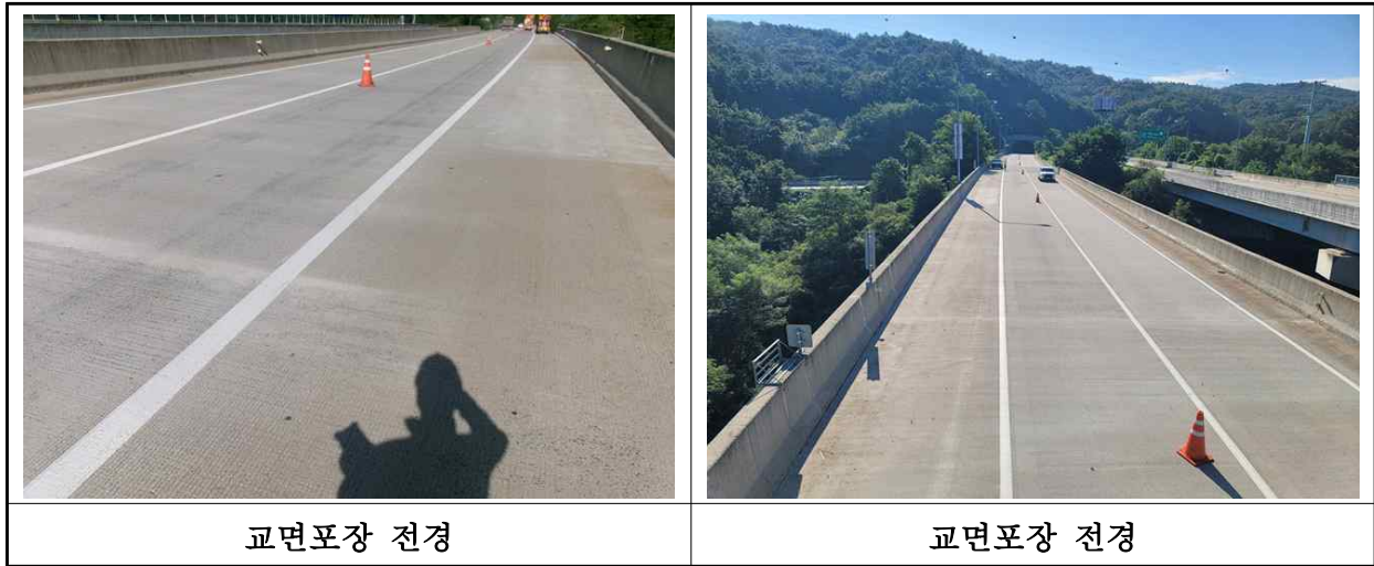
【사진 13.3.20】 교면포장 전경
