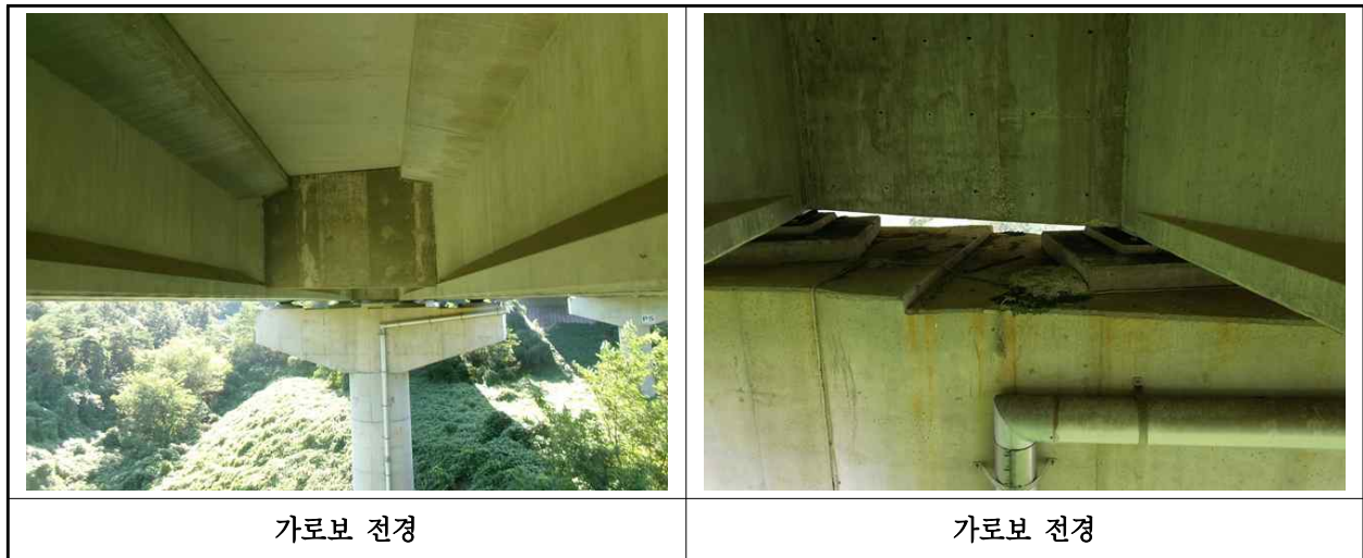
【사진 13.3.6】 가로보 전경
