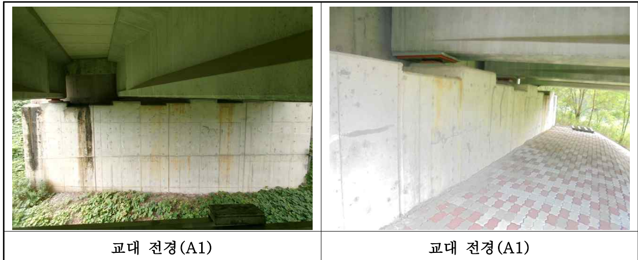
【사진 13.3.33】 교대 전경
