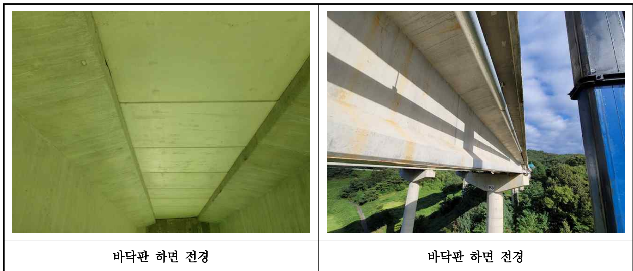
【사진 13.3.27】 바닥판하면 전경
