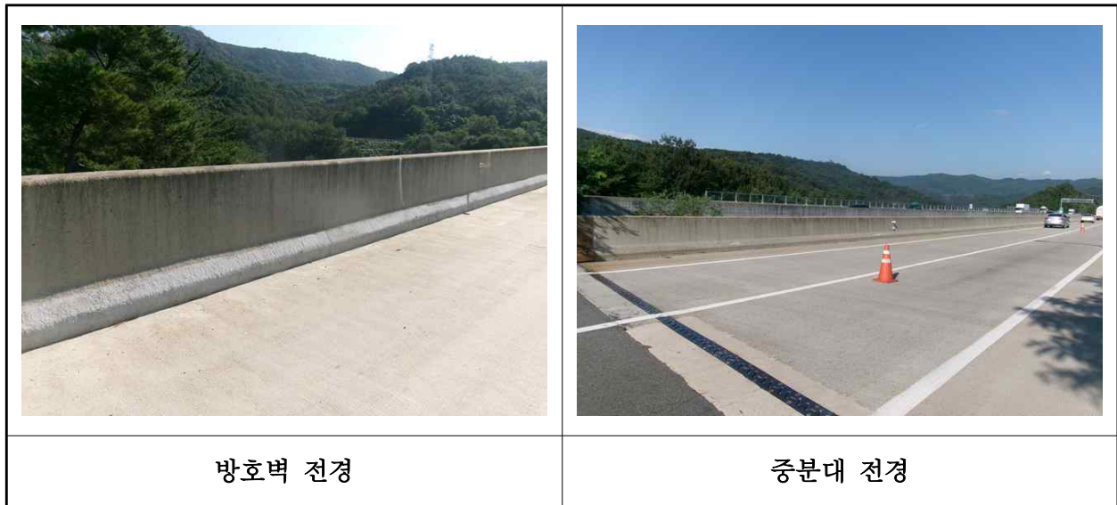
【사진 13.3.24】 방호벽 및 중앙분리대 전경
