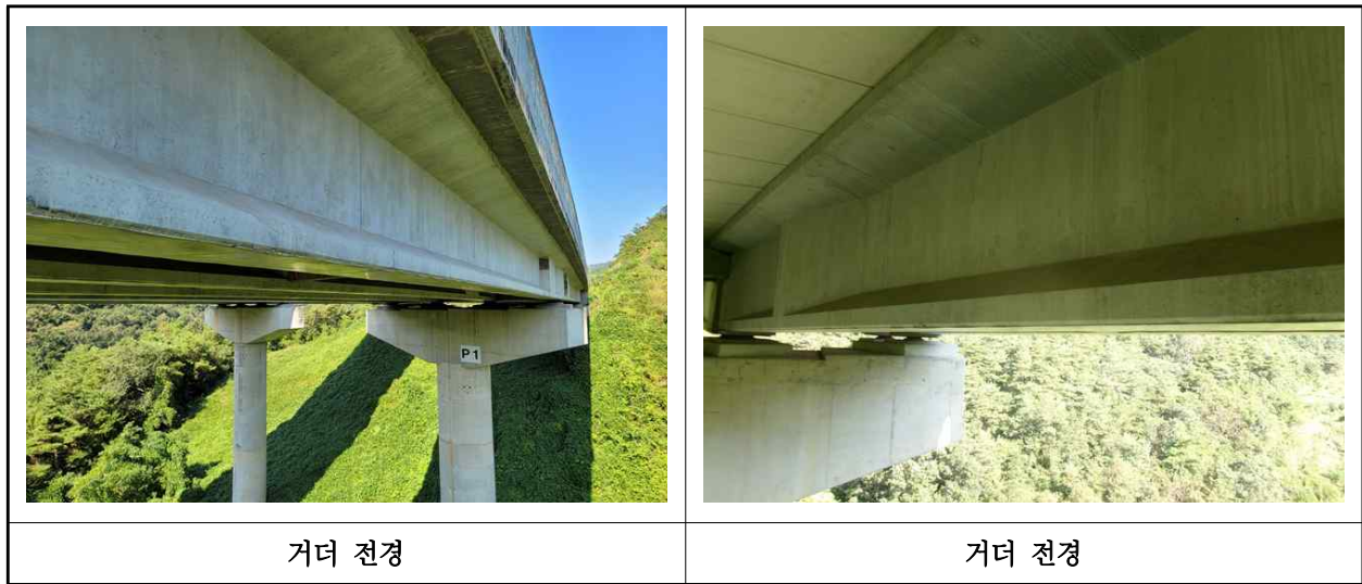
【사진 13.3.4】 거더 전경
