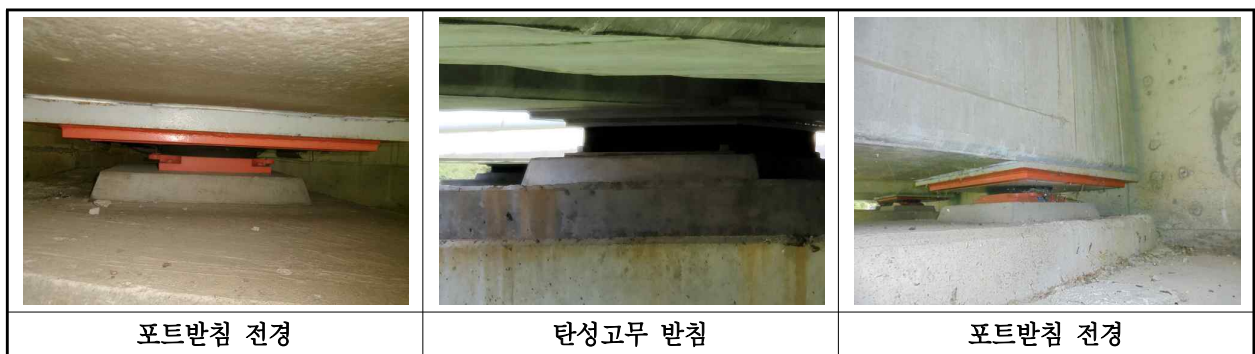
【사진 13.3.38】 교량받침 전경
