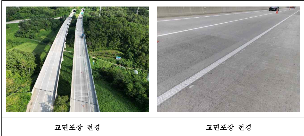
【사진 13.3.45】 교면포장 전경
