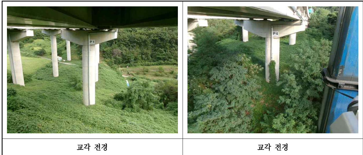
【사진 13.3.35】 교각 전경
