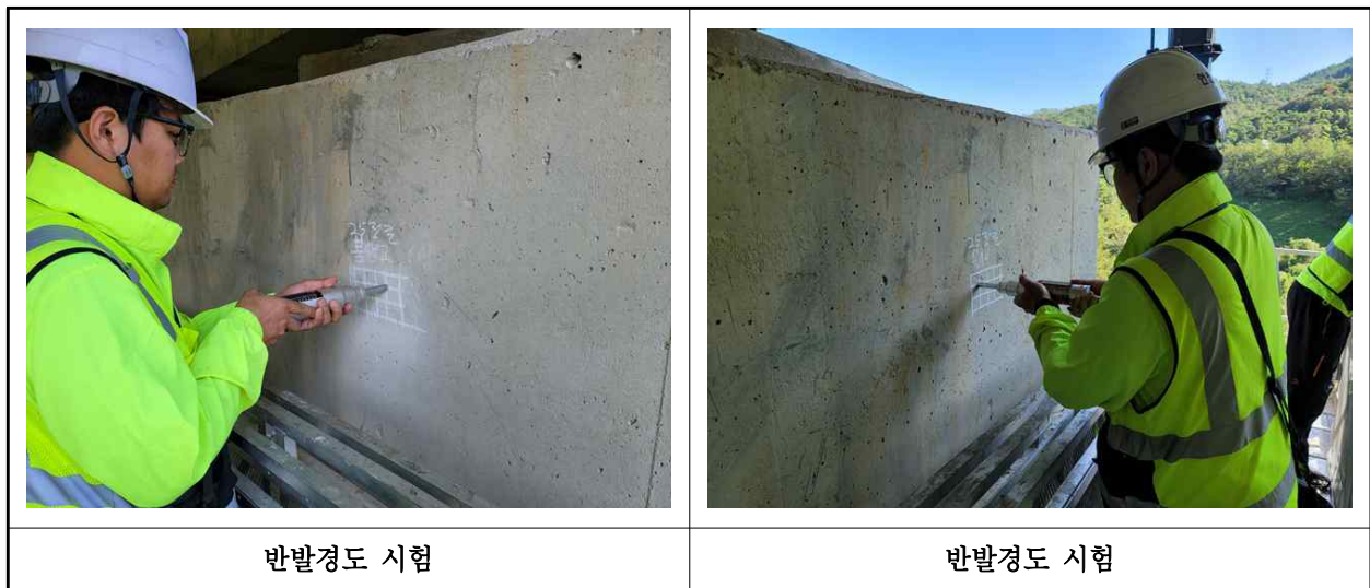
【사진 13.4.2】 반발경도시험 현장사진
